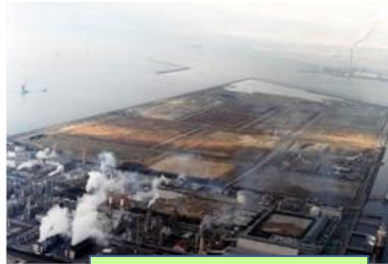
堺第7-3区埋め立て処分場全景
