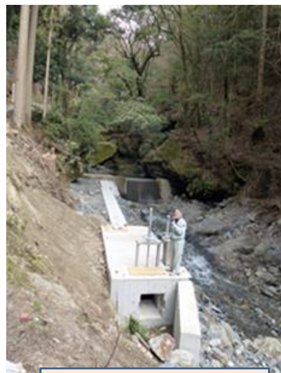
東吉野発電所取水場の工事
